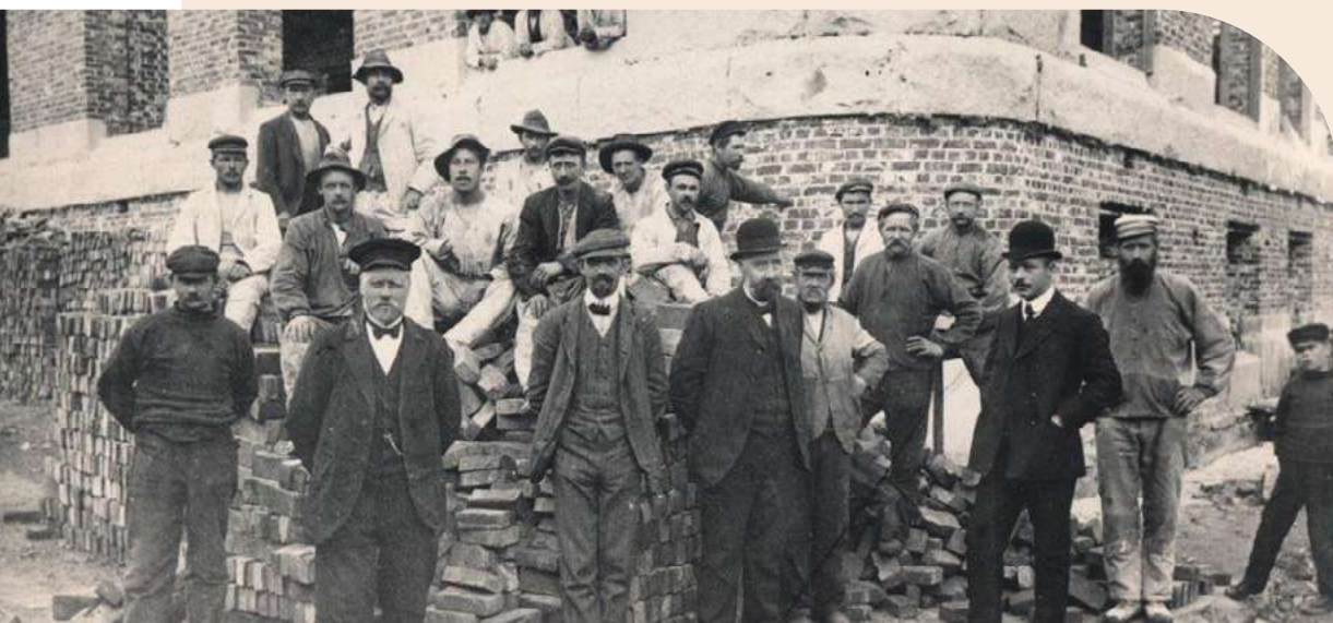
BYGGER BANK: Fra byggingen av Rødbanken i Tromsø. Denne sto ferdig i 1912.
